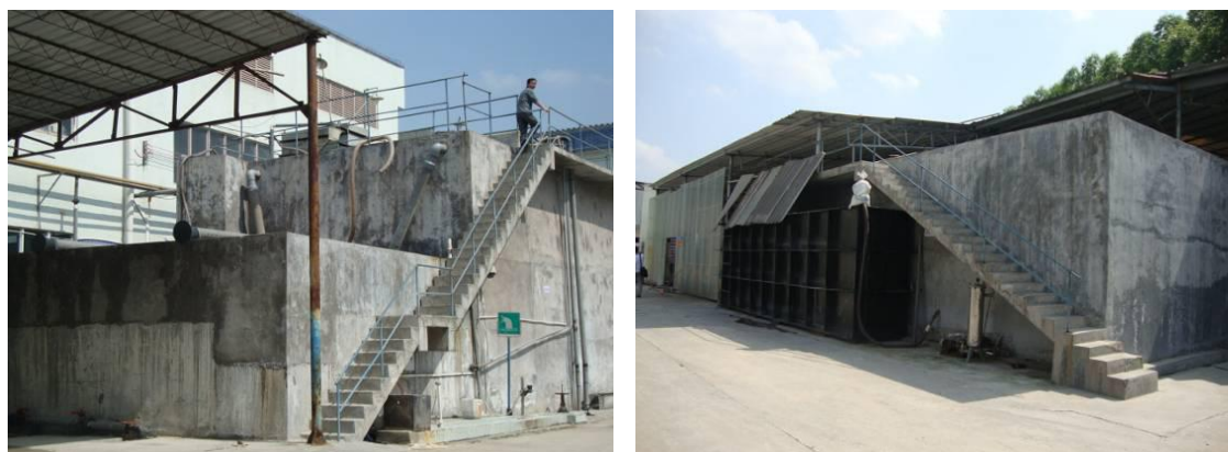
污水处理站全景 1
