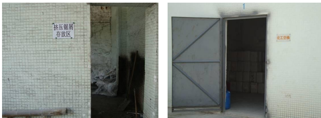
图 2.8-4 一期工程厂区固体废物临时堆放场所
